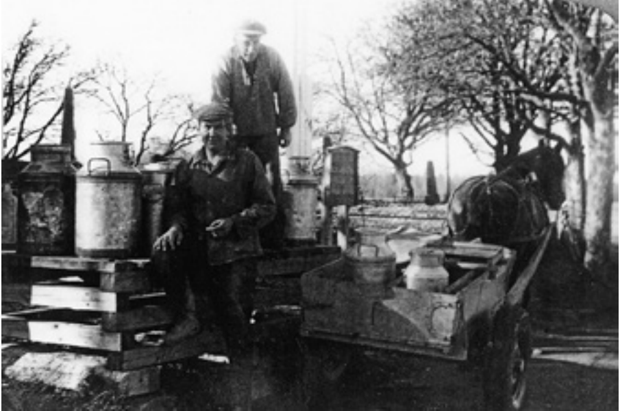
Rampen ved pakkhuset, Vestby stasjon (Foto Arne Fr. Holth)
